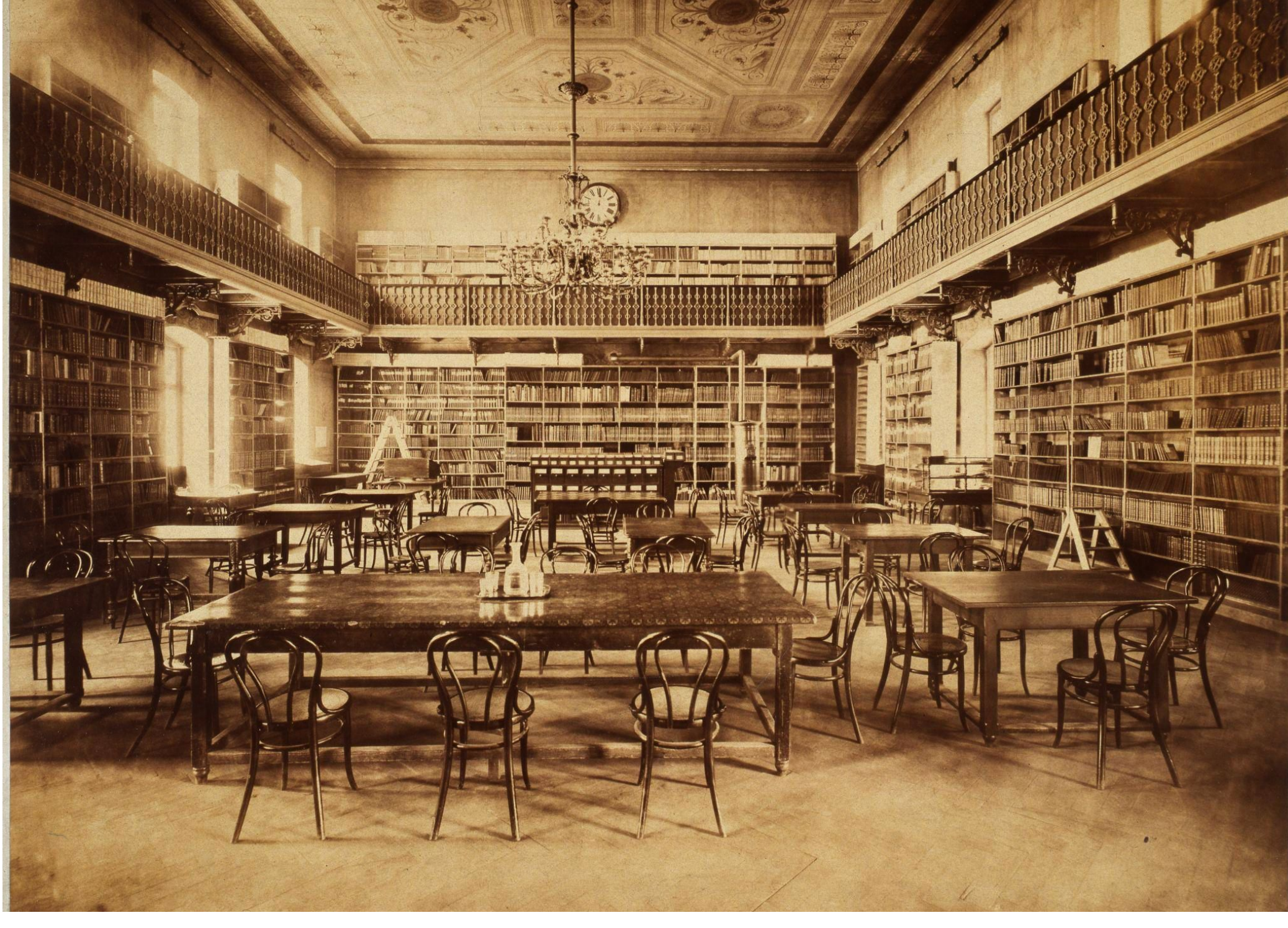
A Fővárosi Könyvtár a központi városháza épületében Capital City Library in the Central City Hall
