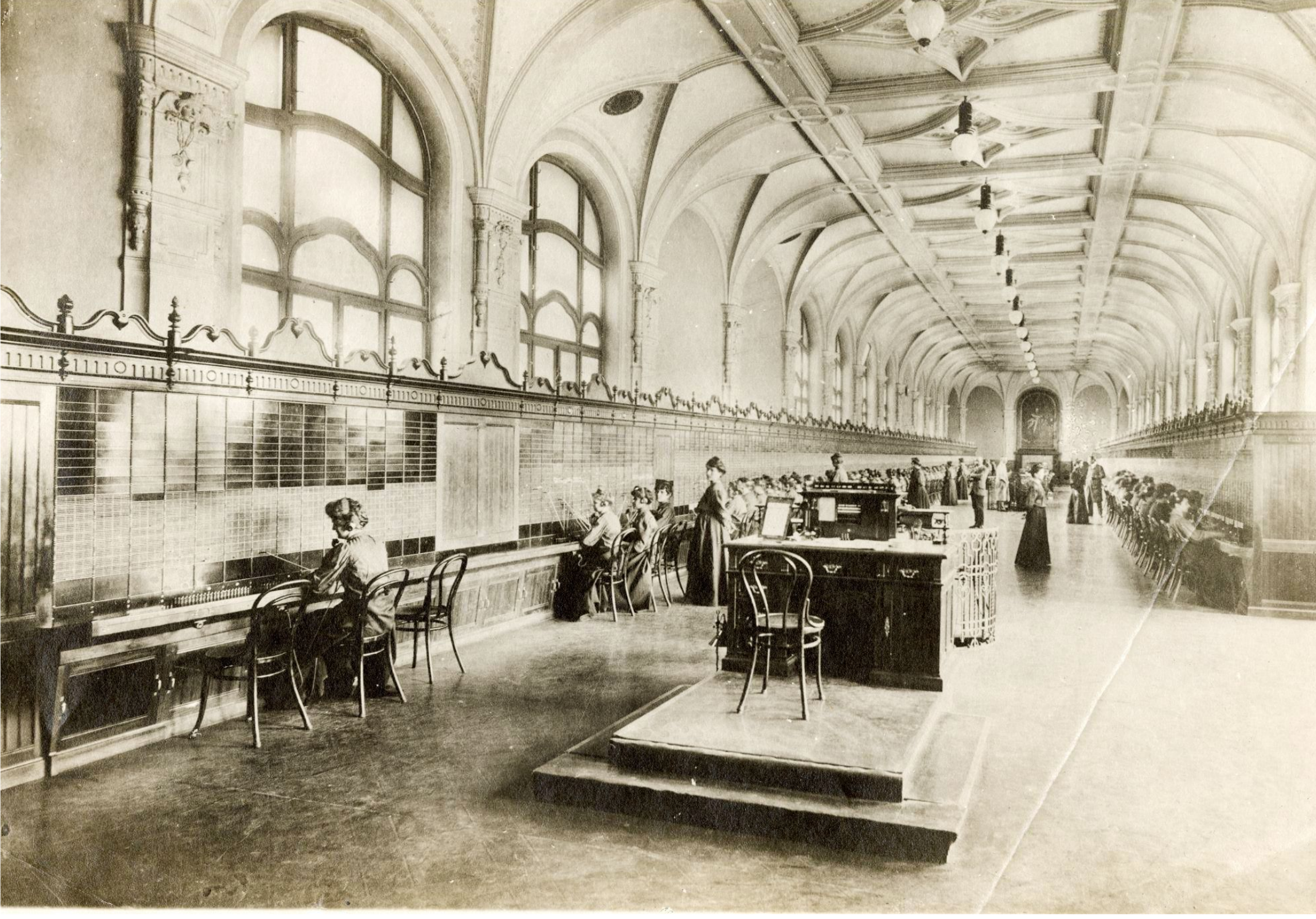
Teréz távbeszélőközpont Teréz telephone exchange
